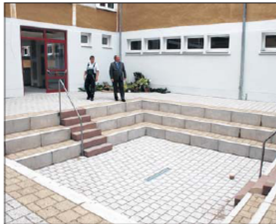
An Stelle des ehemaligen Schwimmbades entstand ein neuer Innenhof, den Hausmeister Rainer Fanselow (l.) Oberbürgermeister Zok zeigt.
