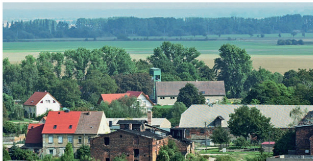
Auch die Saaleinsel Gottesgnaden profitierte von der Leader-Förderung. Hier ein Archivfoto des Ortsteils, das den Saalehof vor seiner Sanierung zeigt.
