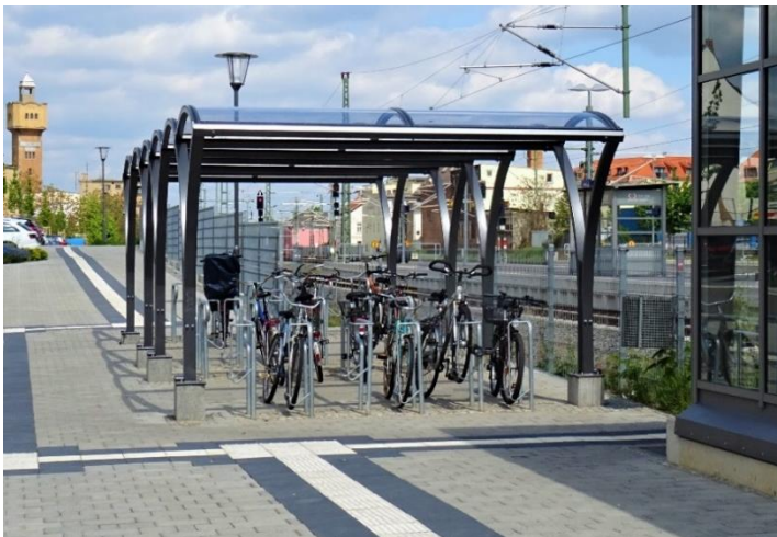
Geförderte Fahrradabstellanlage am Bahnhof Merseburg
